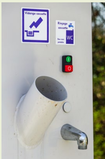
Hier kann die Kassette auch mit Wasser gespült und gefüllt werden.
