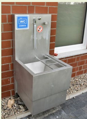
Für die Abwasserentsorgung sind Reisemobilisten auf eine Entsorgungsmöglichkeit angewiesen (oben). Die Kassettentoilette muss in einem Ausguss mit Kanalanschluss entleert werden (re.).
